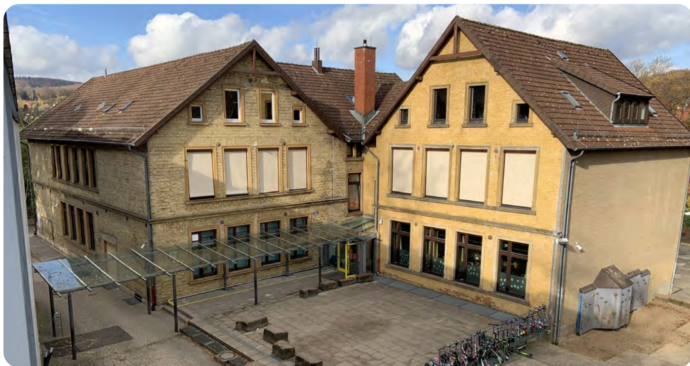
Der Blick auf unsere Schule von der Feuertreppe des Neubaus.
